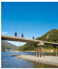
名越屋沈下橋
